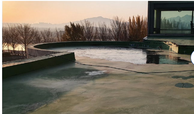
곡면부 시공 전
