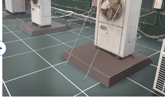
실외기 주변부 시공 후
