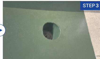
드레인 보강판 설치 후 내부 실리콘 보강
