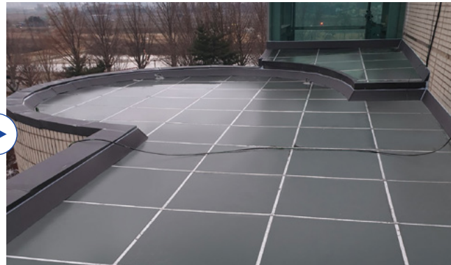
곡면부 시공 후
